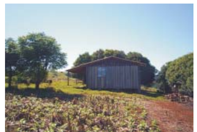
A falta da luz elétrica impede que o casal se mude para sua casa, que está pronta há dois anos.
